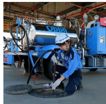
給油設備の点検業務
