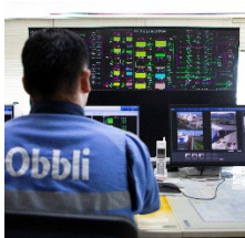
コントロールルームでの監視業務
