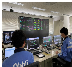
コントロールルーム での監視業務
